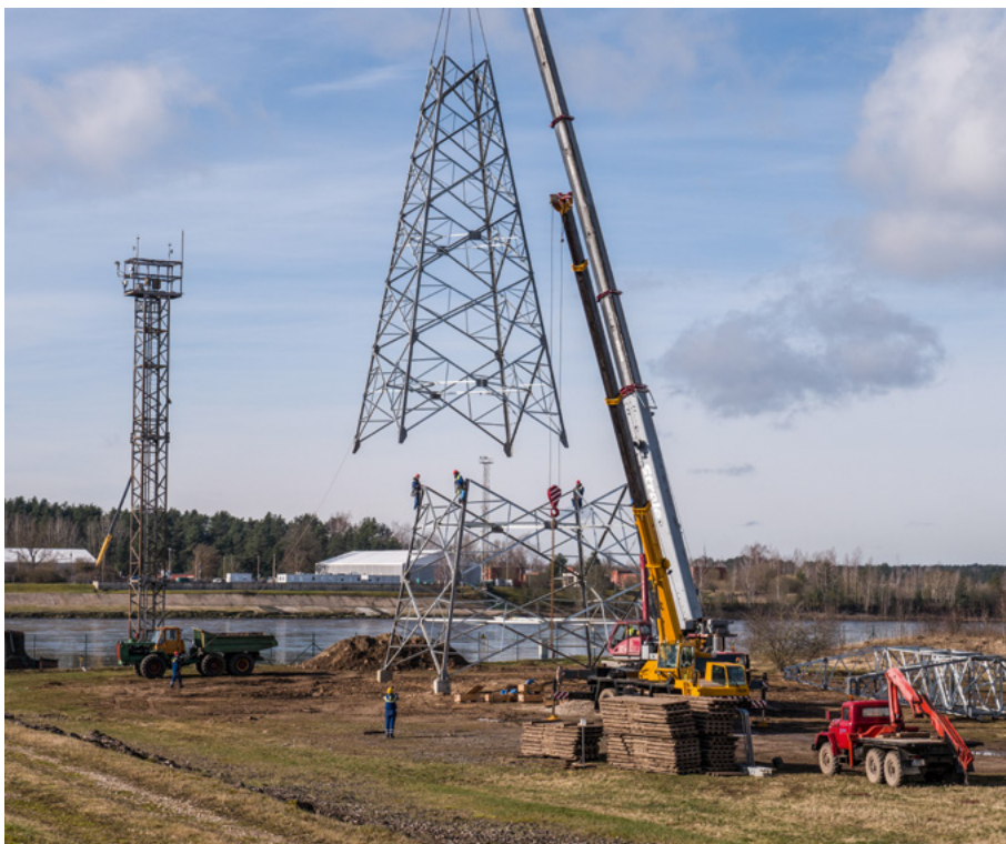
Elektropārvades līnijas starp Rīgas TEC-2 un Rīgas HES balstu pacelšana
